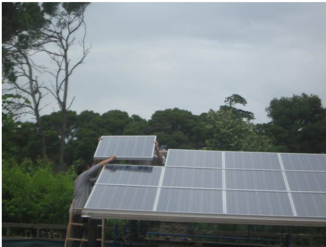
Instal·lació plaques solars (Torre Salduba 2011)
